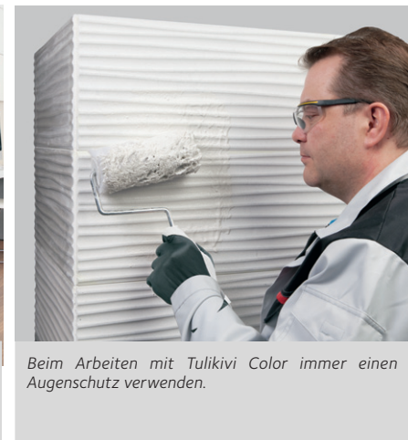
11. Wenn die Beschichtung getrocknet ist, setzen Sie die Tür wieder ein. Jetzt ist Ihr Tulikivi-Ofen wieder neu! Beachten Sie, dass die Oberfläche eine Woche trocknen muss, bevor Sie den Ofen einheizen können.
